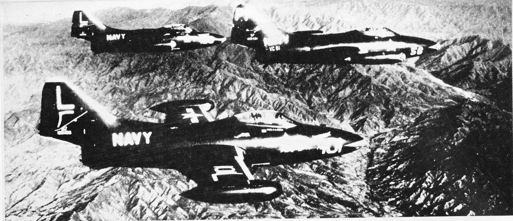
△F9F Panther “黑豹” 格鲁曼公司最早生产的喷气战斗机，1949年装备部队，为美军侵朝时最早使用的喷气机，其性能与米格-15相当。图为“好人李查德”号航空母舰上攻击归来的“黑豹”。F9F-5的主要性能数据为：翼展11.6米，机长11.8米，最大起飞重量9.6吨，时速805公里，装4座20毫米炮。
