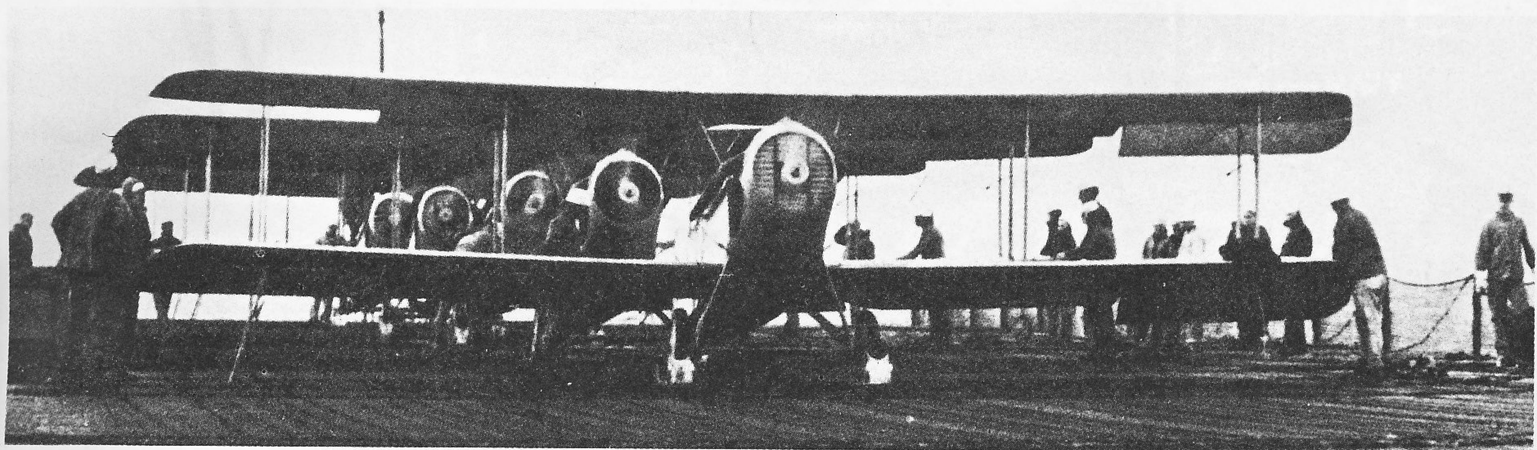
美国海军舰载机始建于本世纪20年代。舰载机除要求具有一般的飞行性能外，其发展还受到更为严格的条件限制。30年代末出现的单翼机，在二次世界大战期间十分活跃。战后，又出现了喷气机，且日趋现代化。下面是各个时期具有代表性的机种。上图：1922年，“兰利”号（CV-1）上由VE-7 SF战斗机编成的第一飞行中队。
