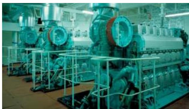
瓦锡兰Auxpac发电机组是当前市场上最紧凑，最轻便的发电机组。紧凑的设计节省了机舱内宝贵的空间。轻便的发电机组更容易安装并减轻了船舶整体重量。
