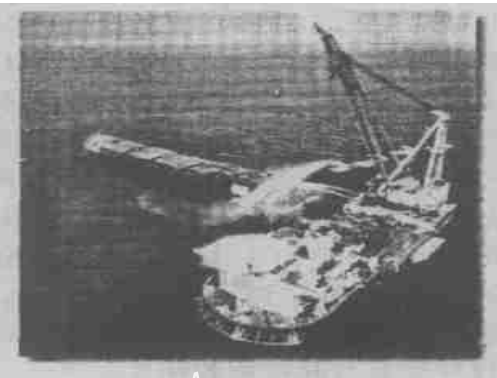
图3 Spar 的倒装(Upend)过程
