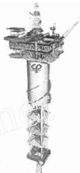
图 4 桁架式单柱平台
