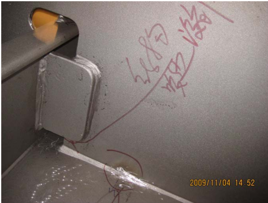
11: 复板下边口焊缝差 (---结构报检阶段清除)
