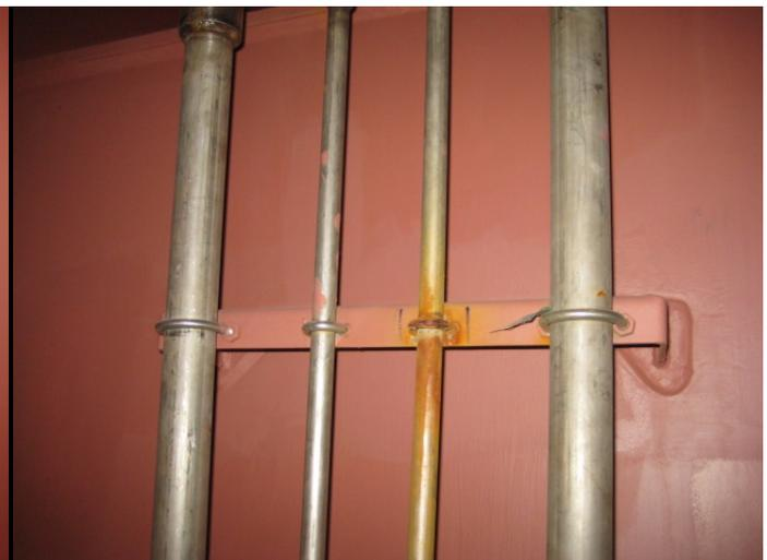
2: 如果错误的材料 U 型螺栓,必须进行更换至正确材料. 同时对不锈钢套节,电焊及打磨后在适当的时期进行钝化. 钝化处理要求由油漆部门按照相关工艺进行, 避免其他工种不小心的施工导致钝化液滴在油漆表面,损坏油漆质量.
