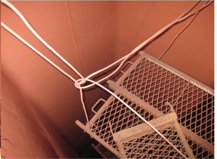
6: 在槽型舱壁处的脚手架,有些太低,油漆工不够高,不利于反顶的打砂皮纸的 DFT 检查. 并且空间宽度太大,不安全
