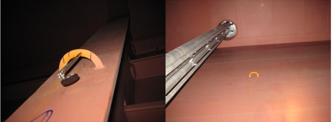
3: 错误材料的半圆形吊耳,必须更换至正确的材料
