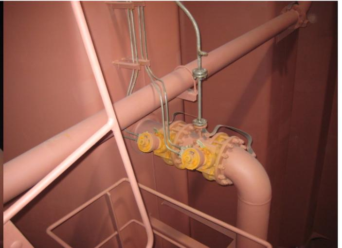
1: 对于厂家来货的阀门, 要求不锈钢液压管和顶部转轴及批示针盘进行妥善包覆盖保护, 不进行冲砂和油漆. 但其它表面进行扫砂和油漆
