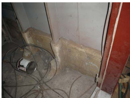
(舱壁绝缘的延伸)
