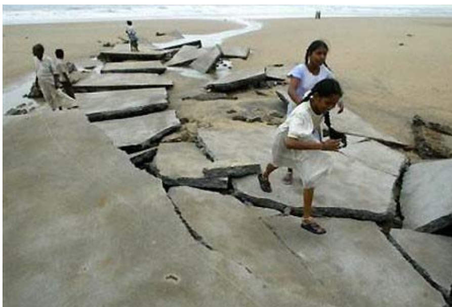
照片 7 南亞海嘯產生海岸道路鋪面破壞(引自網址 teach.whes.tpc.edu.tw )
