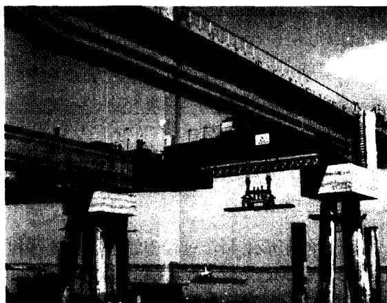
图 1 码头中的特大型悬臂式变截面钢箱梁
