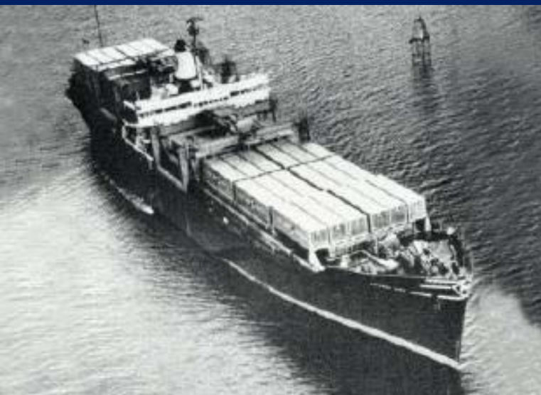
1957年，世界第一艘全集装箱船——盖脱威城号（SS Gateway City）投入运营，只能装载226只集装箱。
